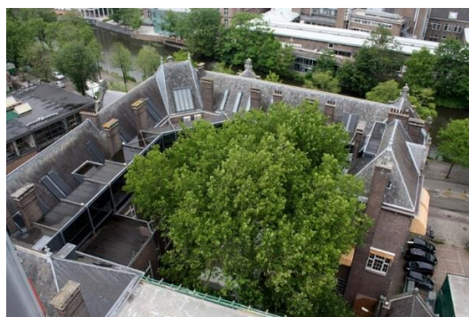
Foto vanuit de bouwkraan op de Mauritskade (Renate Klinkenberg)
